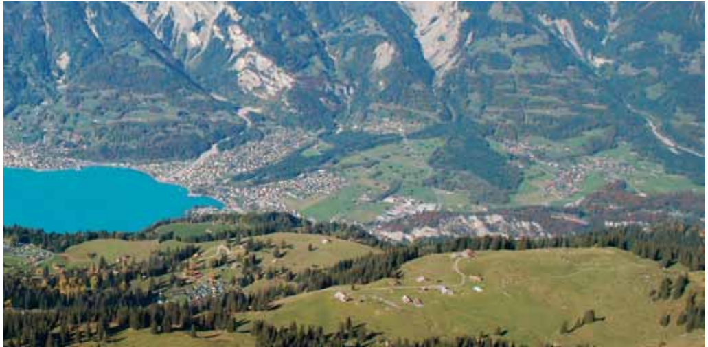
Axalp und Brienz von Süden; Kienholz (im Bildzentrum).
