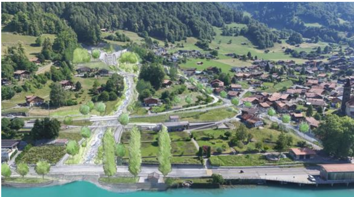
Abbildung 10 Gesamtansicht des Projekts.
