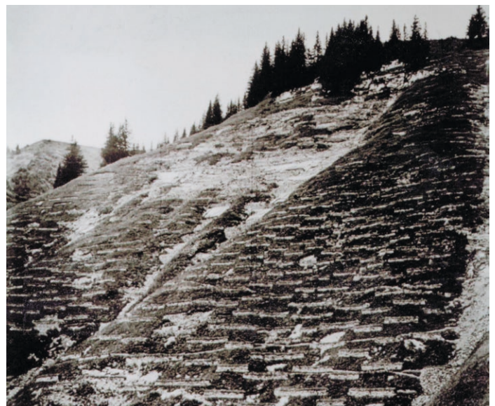
Gemischte Erdterrassen mit Aufforstung in den Allmendemädern westlich von Irtschelen (Foto von 1926)
