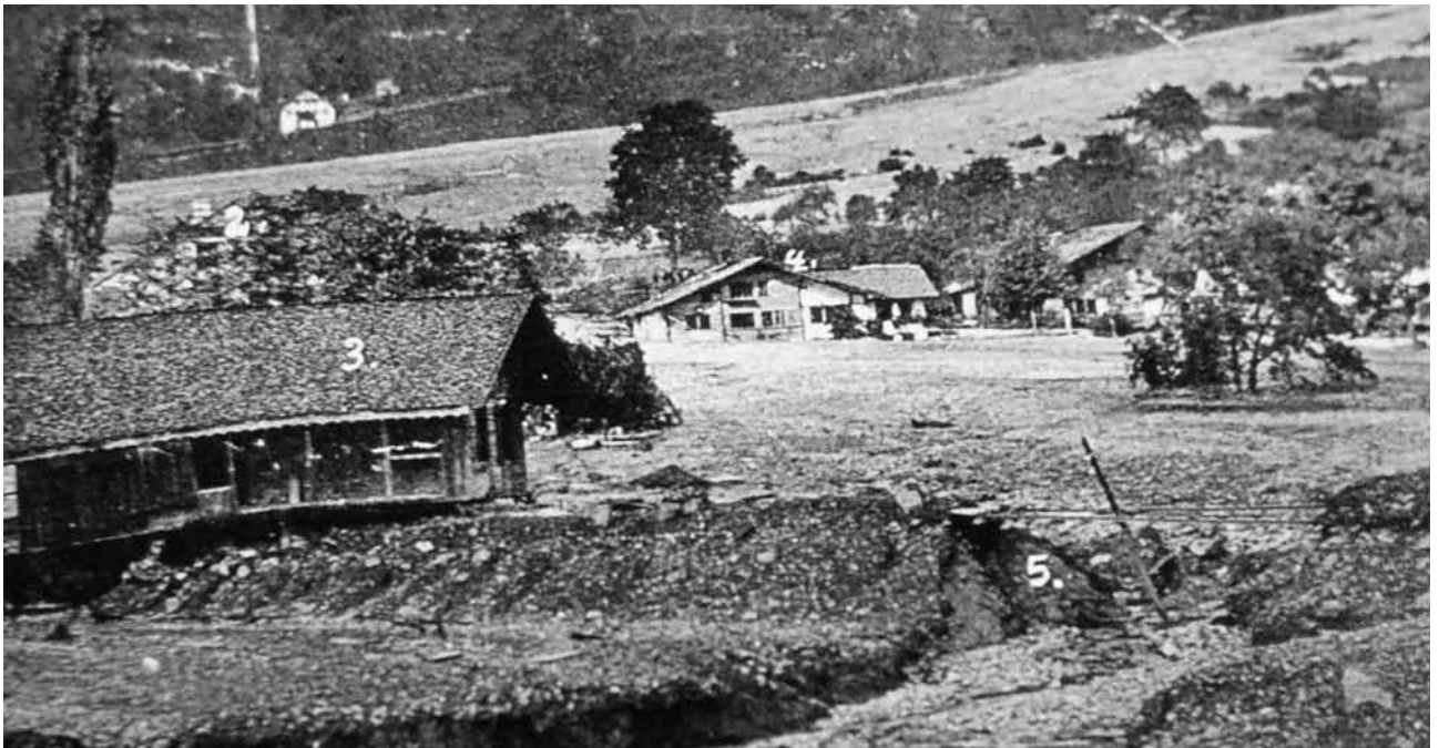
Die Lambachkatastrophe von 1896: Im Vordergrund (Nr. 5) das zerstörte Bahngeleise der SBB; im Hintergrund (weiss) das alte Schulhaus von Schwanden.
