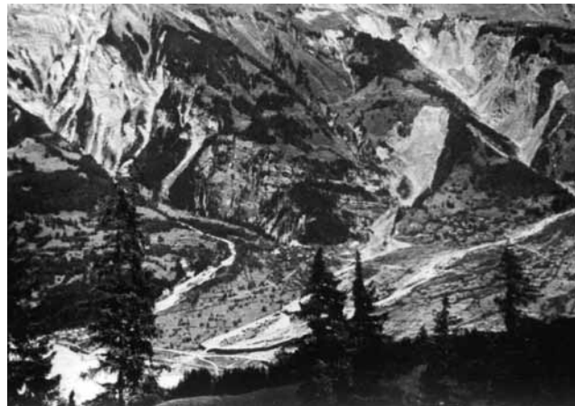
Die bereits vollendeten Umfangsdämme von Lamm- und Schwanderbach.
