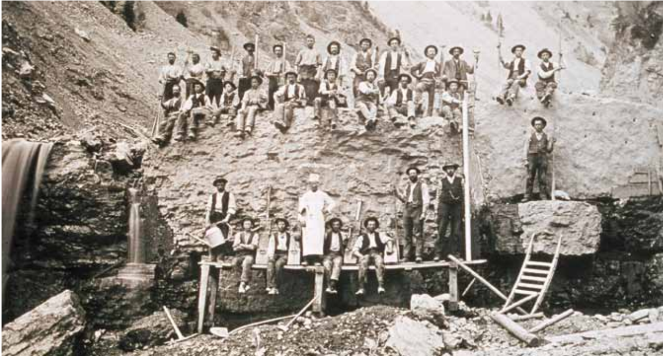
Bau der Sperre Nr. 1 (Baubeginn Herbst 1896).
