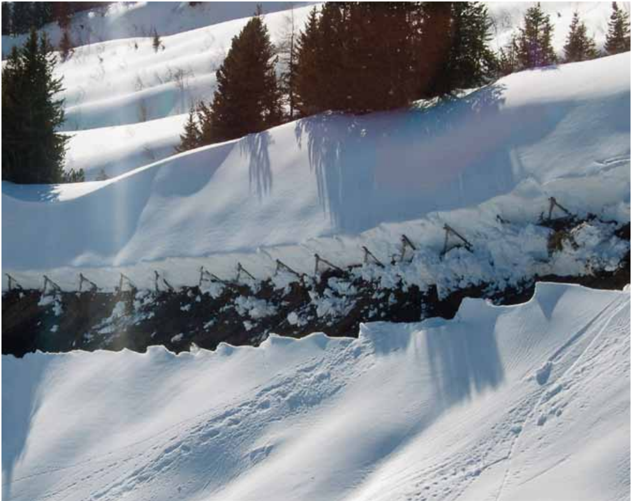
Die Dreibeinböcke verhindern das Abgleiten der Schneedecke und schützen dadurch die jungen Pflanzen.
