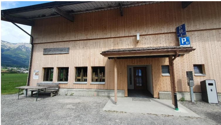
Vor dem Forsthaus (Eingang, Westseite)
