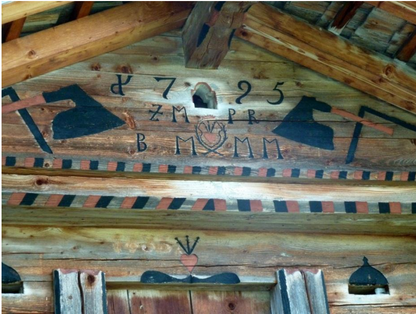
Abb. 18: Frontseite des Speichers im Farnigenboden (Axalp)
