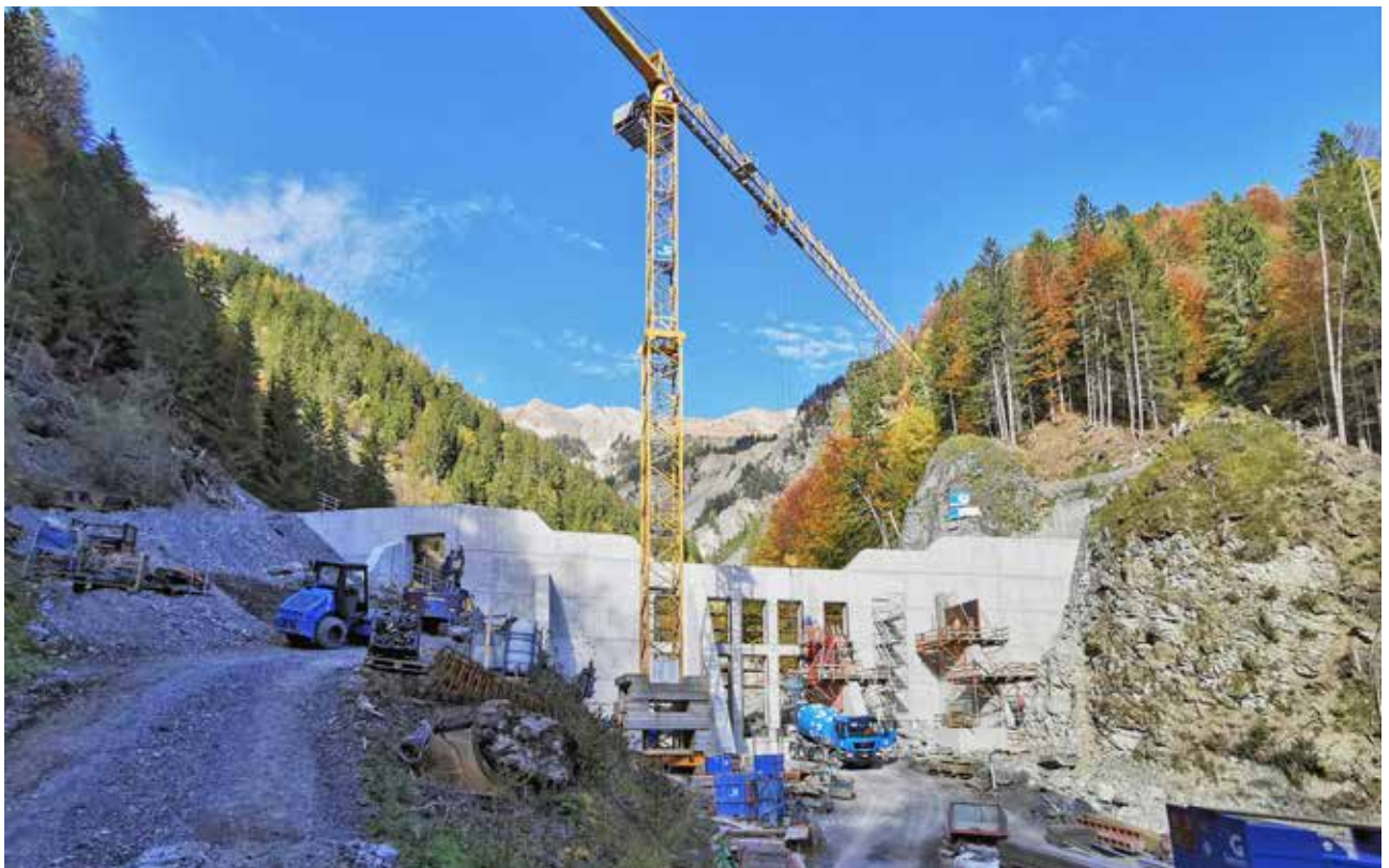
Der Geschiebesammler Roossi oberhalb von Oberschwanden hat seine endgültige Form angenommen.
